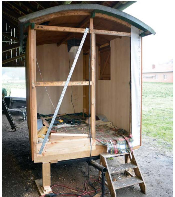
Der Itzelberger Wagen wurde komplett entkernt und neu aufgebaut. Nur der Rahmen aus Eschenholz, das verzinkte Blechdach sowie das Fahrgestell mit Deichsel und Feststellbremse bleiben original erhalten. Die Deichsel wurde zu einer Steckdeichsel umgebaut, um den Wagen vor allzu leichtem Diebstahl zu schützen.
