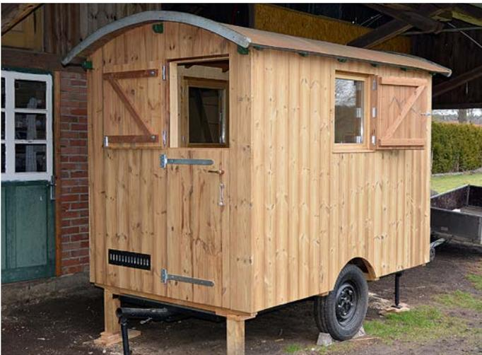
Fast fertig: Die Tür wurde geteilt und zusätzliche Belüftungsschlitze eingebaut.
